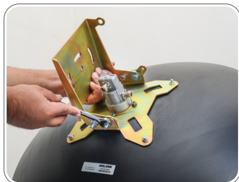
۳- نحوه اتصال براکت به پایه ستاره ای
